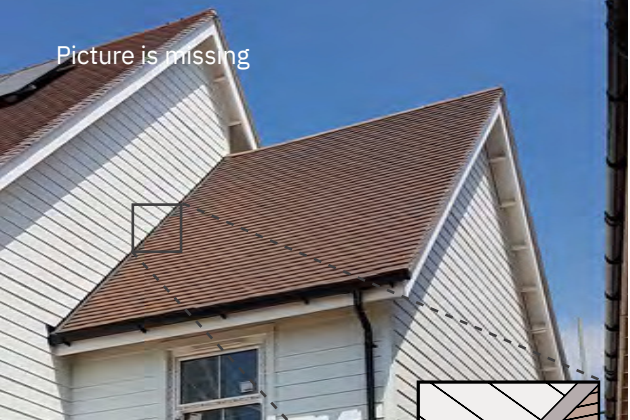
Laikykite ne mažesnę kaip 50 mm tarpą tarp Hardie® VL Plank fasado lentos ir kieto paviršiaus, pvz., stogo, betoninių takų, laiptų ar kiemo dangos.
